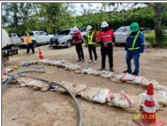
การล้อมกระสอบทรายเพื่อจำกัดบริเวณโคลนโซเดียมเบนโทไนท์ที่รั่วไหล
