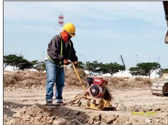
ฎ) การบดอัดพื้นบ่อและผนังบ่อทิ้งโคลนโซเดียมเบนโทไนท์ (ช่วงเตรียมบ่อ)
