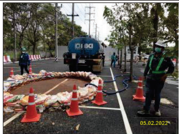
การล้อมกระสอบทรายเพื่อจำกัดบริเวณโคลนโซเดียมเบนโทไนท์ที่รั่วไหล
