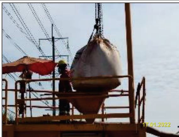
ข) การผสมโซเดียมเบนโทไนท์ให้พอดีเพื่อใช้ในการเจาะลวด
