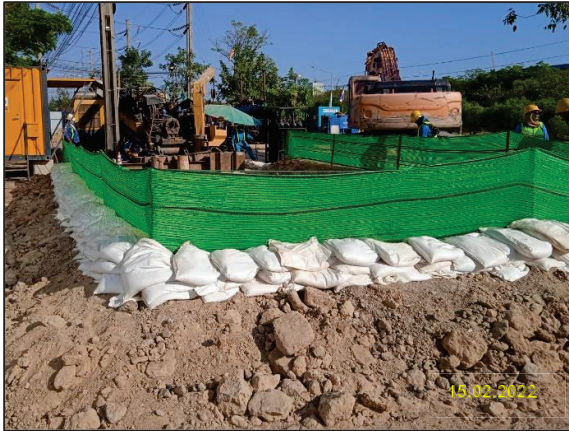
ก) จัดวางถุงทราย และจัดทำคันดินรอบพื้นที่บ่อรับ และบ่อส่ง
