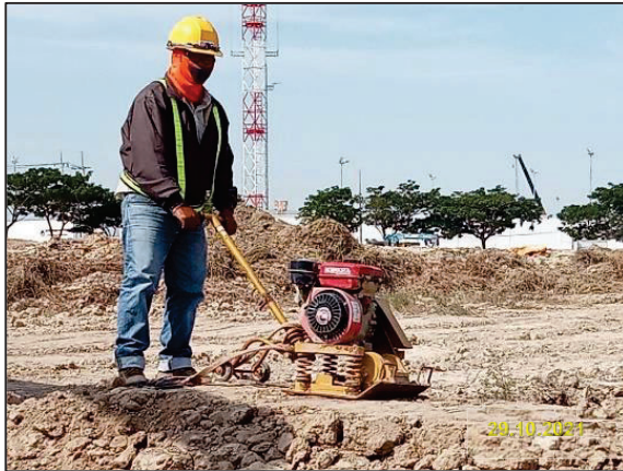
ฎ) การบดอัดพื้นบ่อและผนังบ่อทิ้งโคลนโซเดียมเบนโทไนท์ (ช่วงเตรียมบ่อ)
