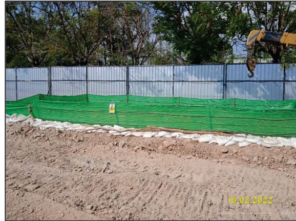
ก) จัดวางถุงทราย และจัดทำคันดินรอบพื้นที่บ่อรับ และบ่อส่ง
