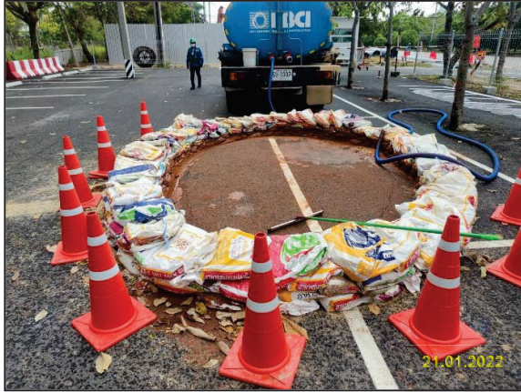
การติดตั้งโคลนโซเดียมเบนโทไนท์ด้วยรถดูดสูญญากาศ
