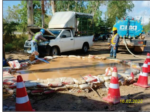
การติดตั้งโคลนโซเดียมเบนโทไนท์ด้วยรถดูดสูญญากาศ
