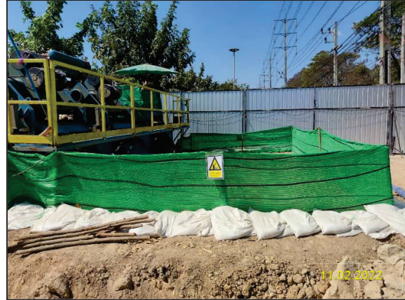
ง) เครื่องแยกทรายออกจากโคลนโซเดียมเบนโทไนท์เพื่อนำกลับมาใช้ใหม่
